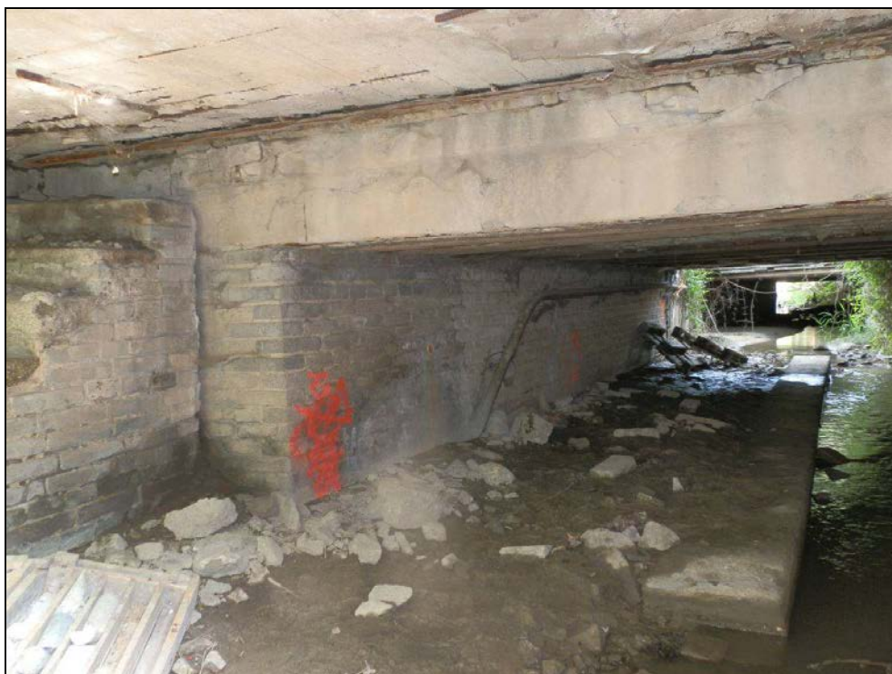
Obr. č. 2 - pohled na opěru Beroun a nosnou konstrukci směrem ke trati. Dodatečná nosná konstrukce nad čelem je pro chodník vedle silnice.
