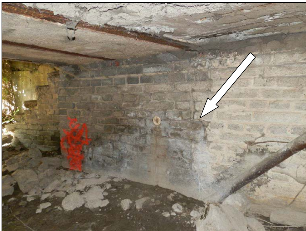
Obr. č. 3 - pohled na opěru Beroun. Objekt byl v minulosti rozšiřován, šipka označuje pracovní spár po rozšíření opěry, změna skladby je v tomto místě i v nosné konstrukci
