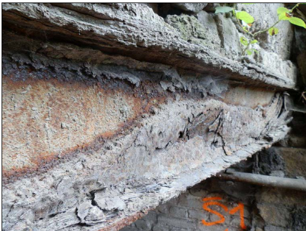
Obr. č. 7 - pohled od trati na boční ocelový nosník nosné konstrukce, který je většinou s extrémní korozí, na zbytku obnažené plochy je koroze hloubková.
