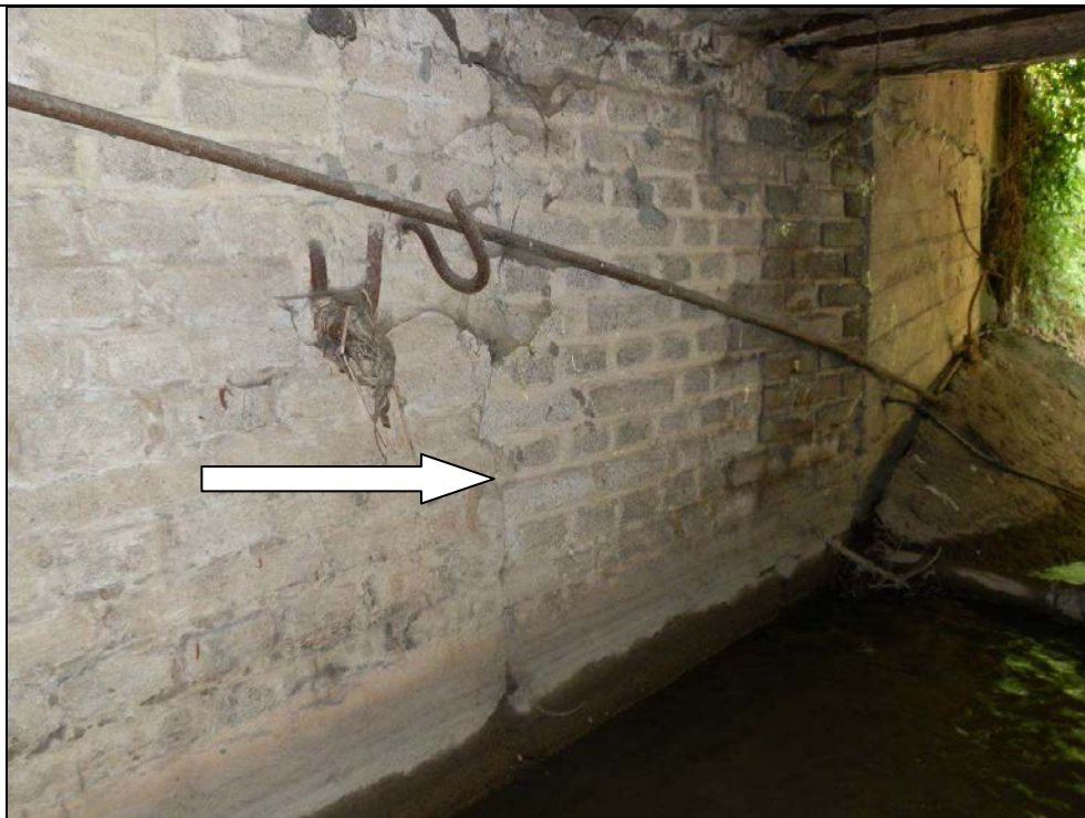
Obr. č. 5 - detailní pohled na opěru Beroun. Šipka označuje pracovní spár po rozšíření opěry, změna skladby je v tomto místě i v nosné konstrukci
