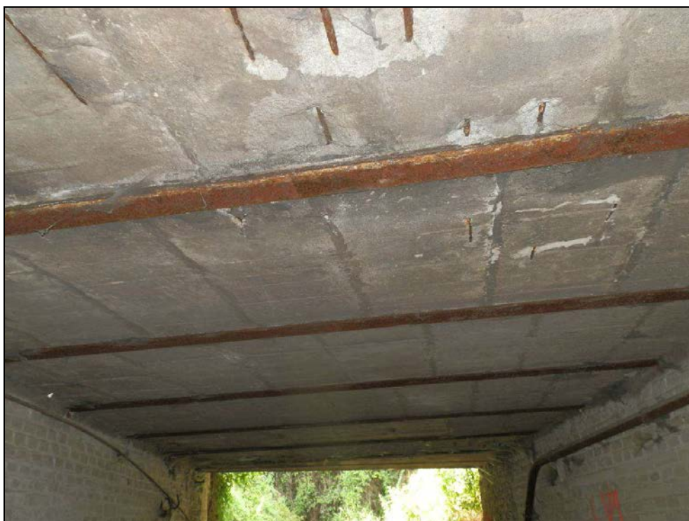
Obr. č. 6 - nosná konstrukce tvořená ocelovými nosníky s obnaženou spodní pásnicí. Výplň mezi nosníky tvoří zřejmě prefabrikované vyztužené betonové desky, které jsou porušené s obnaženou výztuží.
